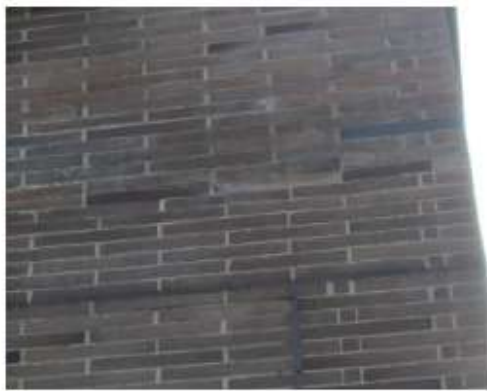
Fotografía 37. Discontinuidad en modulación y junta vertical (2) – muro occidental
