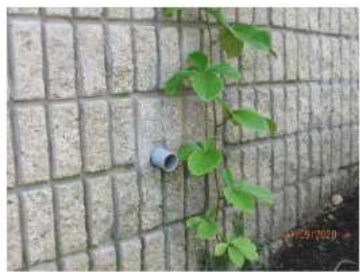
Fotografía 66. Desagües en muro Split
