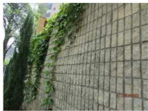
Fotografía 67. Abombamiento central del muro
