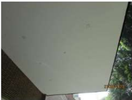
Fotografía 63. Cielo falso sin presencia de humedad
