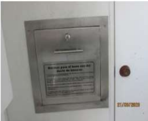
Fotografía 44. Puerta de shut manchada
