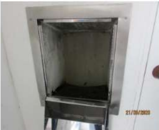
Fotografía 45. Puerta de shut sin empaques
