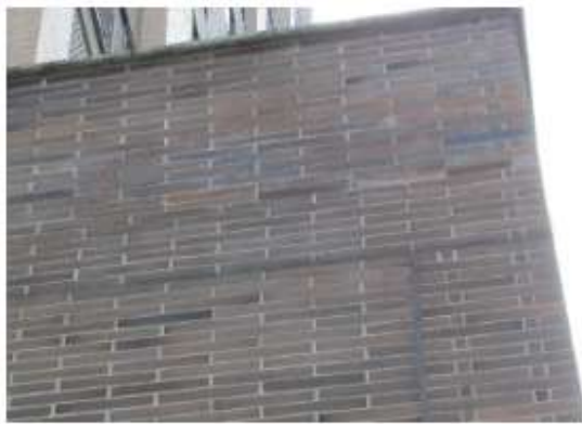
Fotografía 36. Discontinuidad en modulación y junta vertical (1) – muro occidental
