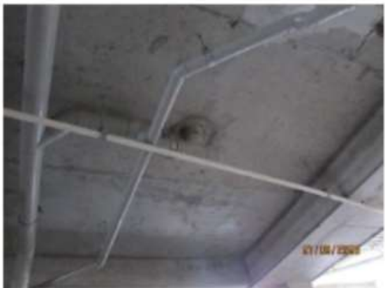
Fotografía 25. Losa sin humedades P2
