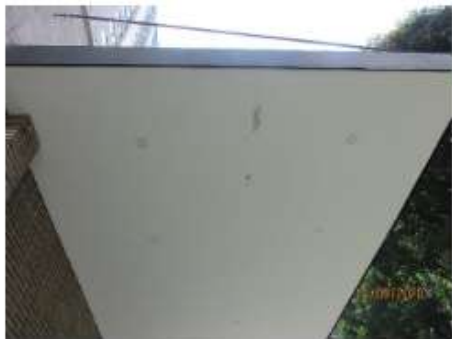
Fotografía 62. Cielo falso con desprendimiento de pintura
