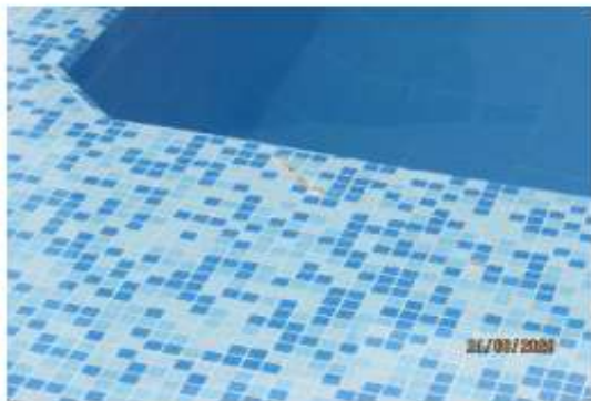
Fotografía 1. Fisura en enchape y desprendimiento de 1 unidad del cristanac en piscina
